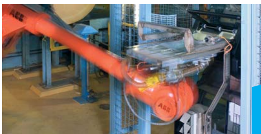
Etikettenübernahme durch den Roboter
